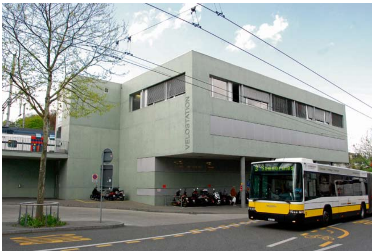
Auf dem Dach der Velostation am Schaffhauser Bahnhof will die private Energiegenossenschaft RandenSaft in diesem Sommer eine Fotovoltaikanlage erstellen. Bild Daniel Jung
