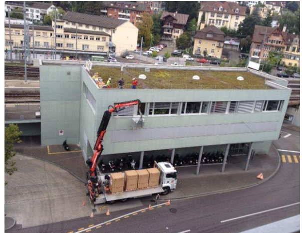
Transport der Module auf das Dach
