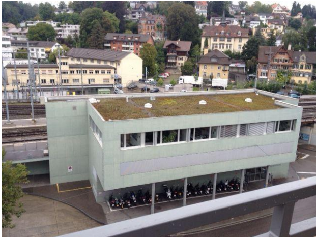
Dach der Velostation vor dem Bau
