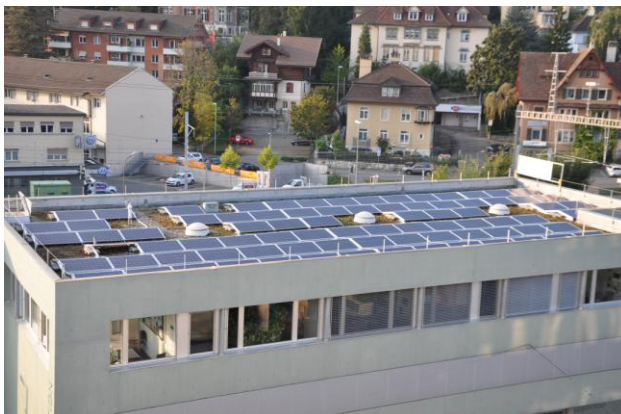
Anlage nach Inbetriebnahme
