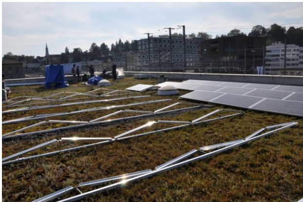
Installation auf dem Dach (1)
