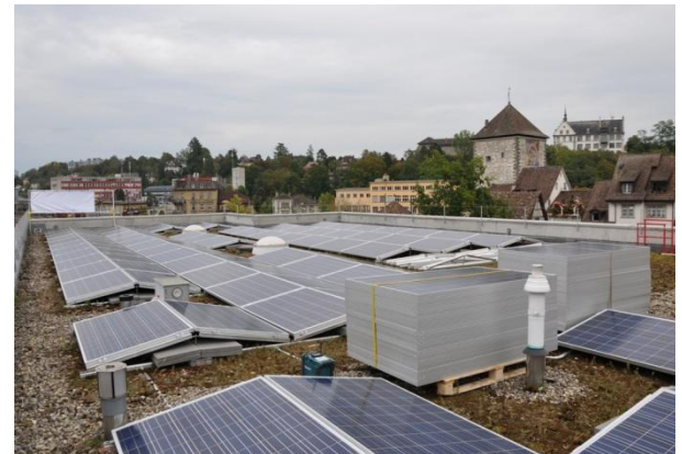
Installation auf dem Dach (2)
