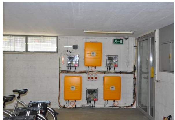
Wechselrichter im EG der Velostation
